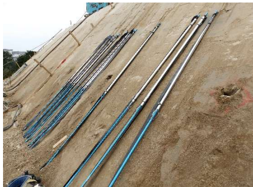
補強材 ステンレス管 炭素繊維ケーブル 魚見団地 施工後
