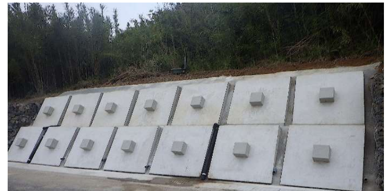
ミニ地すべりではらむ法面を固定（熊毛）
