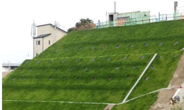
補強材 ステンレス管 炭素繊維ケーブル 魚見団地 施工後
