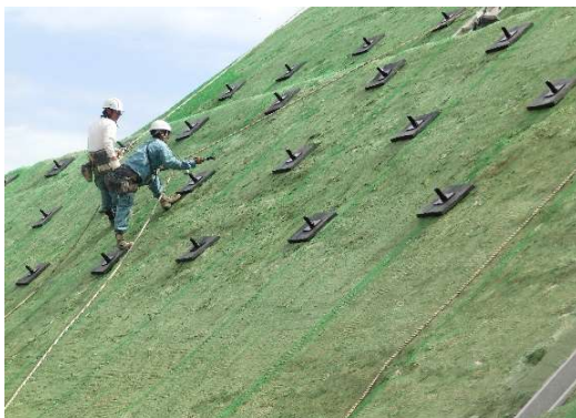
補強材に緊張力導入中
