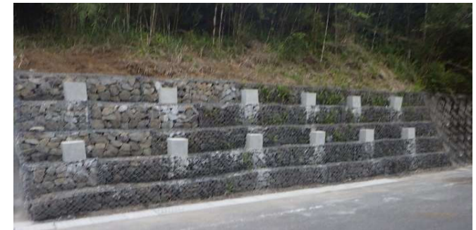
ミニ地すべりではらむフトンカゴを固定（熊毛）
