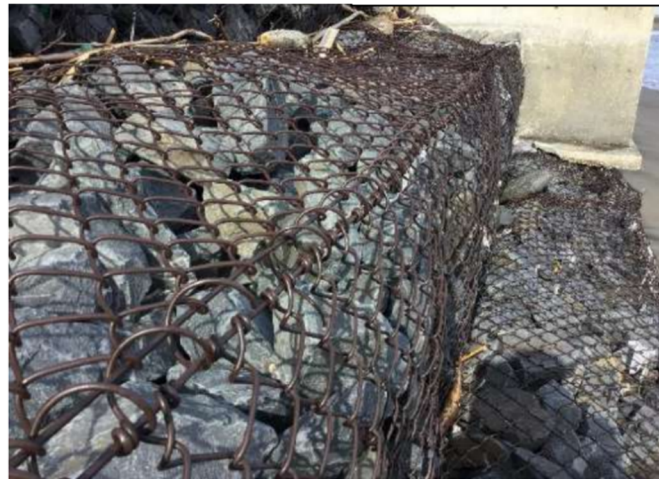
図-6 14年経過後も健全な IR 被覆鉄線かごマット
