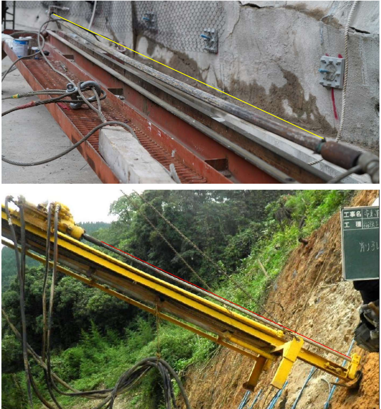
図-3 曲がっている掘削ツール 現場条件Ⅰに使用する
